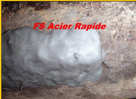
3. OTTURAZIONE DEL BUCO CON F.S.
