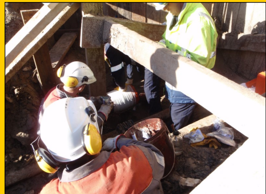
4. COPERTURA CON Bande PR
